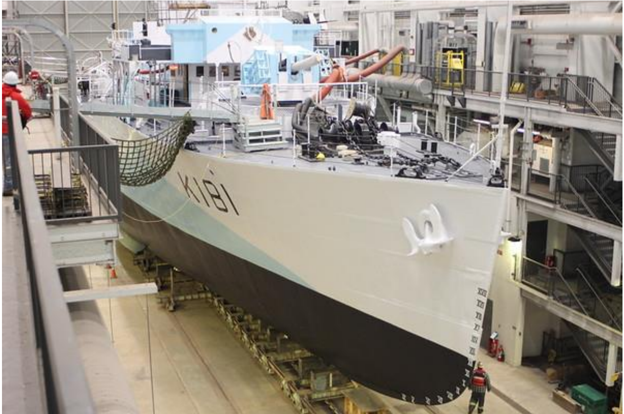
Le radoub de la coque du NCSM Sackville est presque terminé en 2021.
